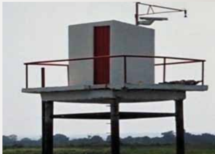
Figura 1. Estación ubicada en Mahates, para registro de transmisión de niveles de agua.
